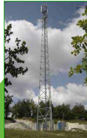
Antenne-relais Bouygues Telecom Pile à combustible Axane
