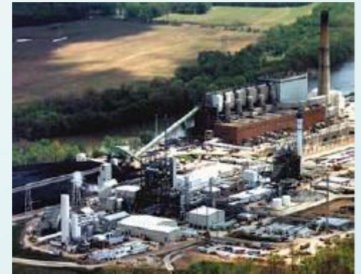
Usine pilote de démonstration pour la gazéification du charbon.
