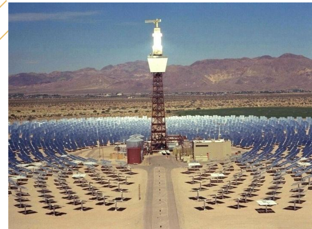
Héliostats et centrale à tour (400-1000°C)
