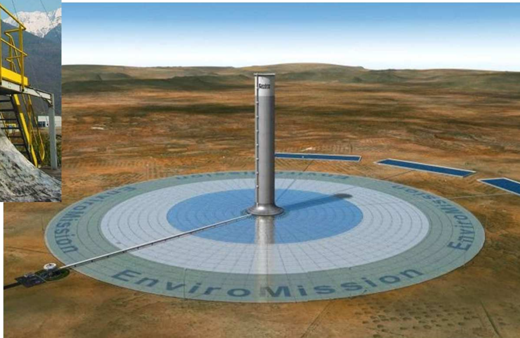
EnviroMission (Arizona) - 750M$ - 200 MWélec. 800m de haut, 10 km 2 , r 1.8km
