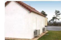
Pompe à chaleur
