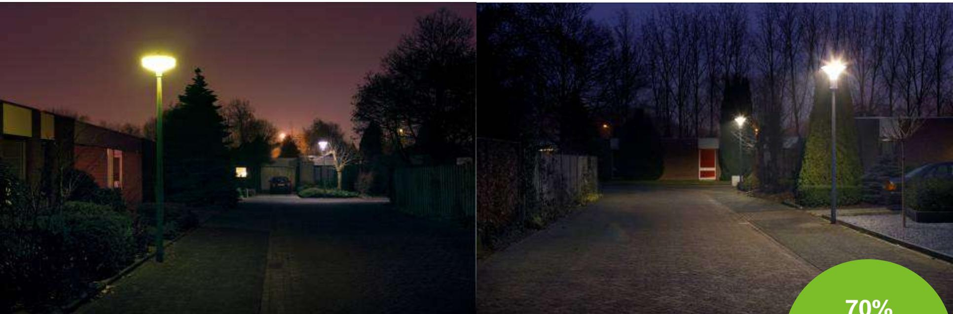
***Luminaire HPL 80 W remplacé par CitySpirit LED 30 W !***
