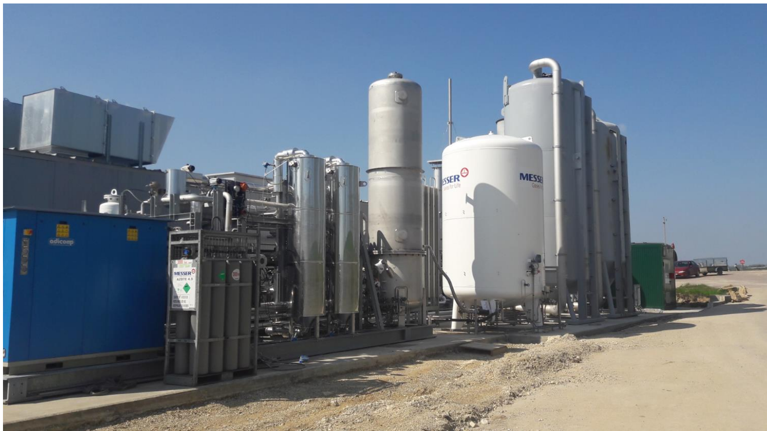
Procédé Wagabox installé à St Florentin (Yonne) - 1 ère mondiale
