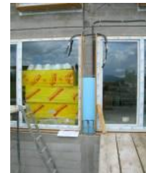
Taitement des ponts thermiques
