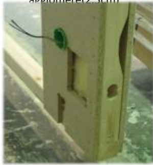
Intégration des réseaux à la fabrication
