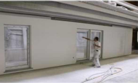
Pose des enduits, menuiseries, parements intérieurs, faïences, en usine
