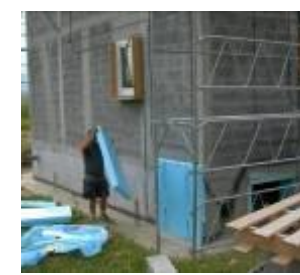
Intégration des menuiseries
