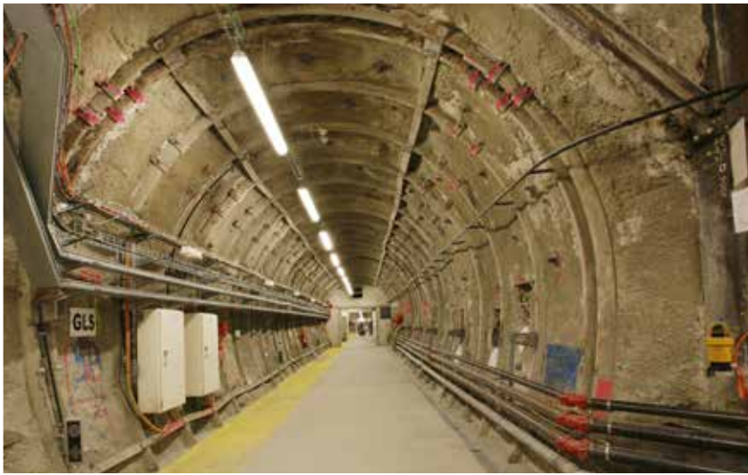
► Galerie du Laboratoire souterrain
