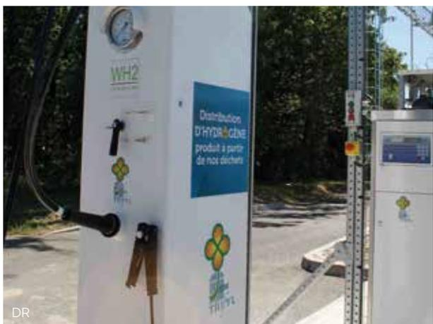
**T**RIFYL dispose d'un bioréacteur pour la valorisation des déchets ménagers de son territoire. La dégradation contrôlée des déchets permet de produire du biogaz. Le projet VaBHyoGaz consiste à convertir ce biogaz en hydrogène 'vert' pour l'alimentation de véhicules hydrogène.
