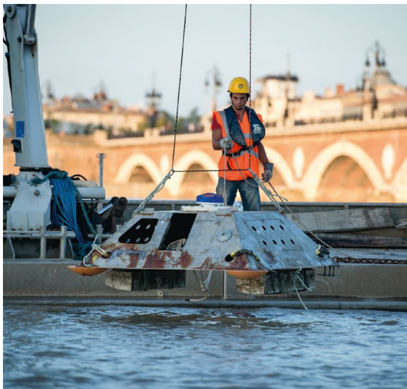
← Campagne de mesures courantologiques sur le site d'essais d'hydrolienne à Bordeaux
