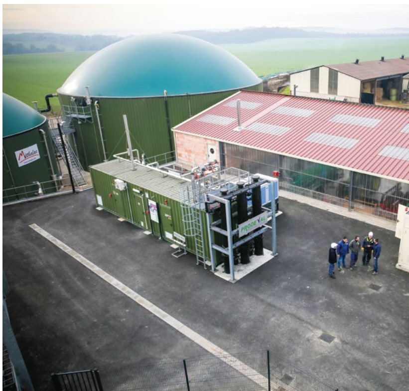
← Unité de méthanisation injectant dans le réseau de gaz
