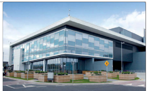
Datacenter de Dublin
