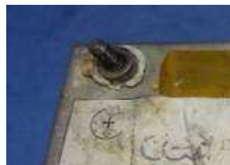
Test de court-circuit
