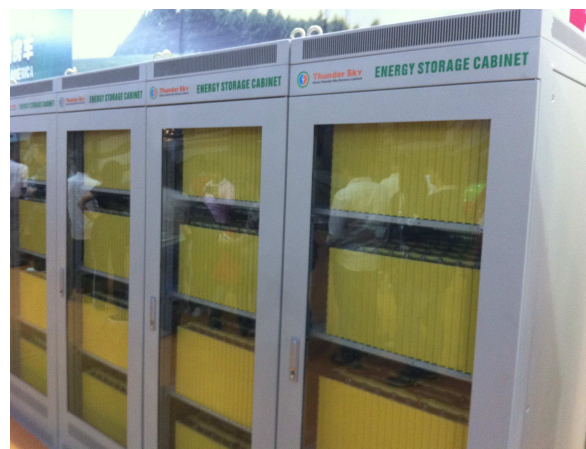
Batterie dans un cabinet pour stockage stationnaire
