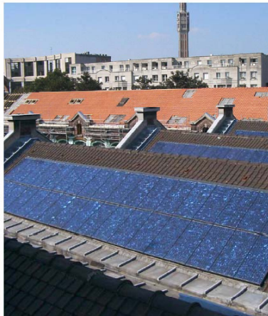
Intégration en toiture
