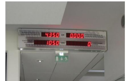
Bureaux Gamba Acoustique
