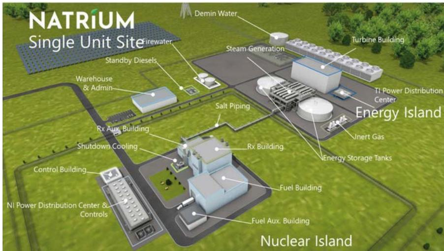
Fig. 6.15 Plan du site d'une installation Natrium à tranche unique. Source : TerraPower.
