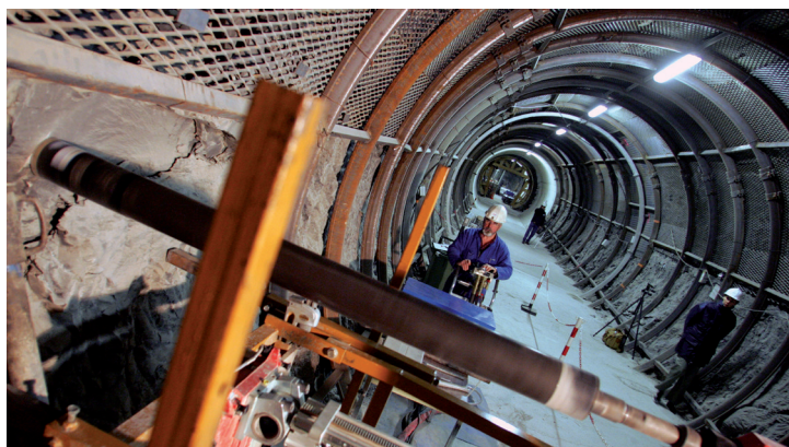
Forage à sec dans une galerie du tunnel expérimental de Tournemire (Aveyron).
